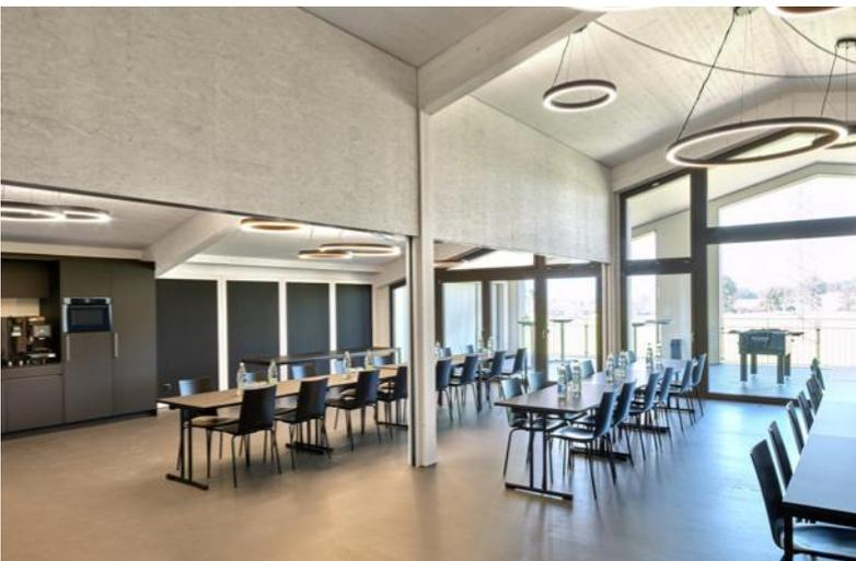
*Einfache Materialisierung: Die Wandverkleidungen aus OSB-Platten sind passend zum Deckenholz hell lasiert.*
